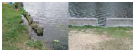
Afb. 1: Visvereniging VIOS Enschede herstelt de oude beschadigde steigers bij de visvijvers aan de Reerinklanden en Buurserstraat.
